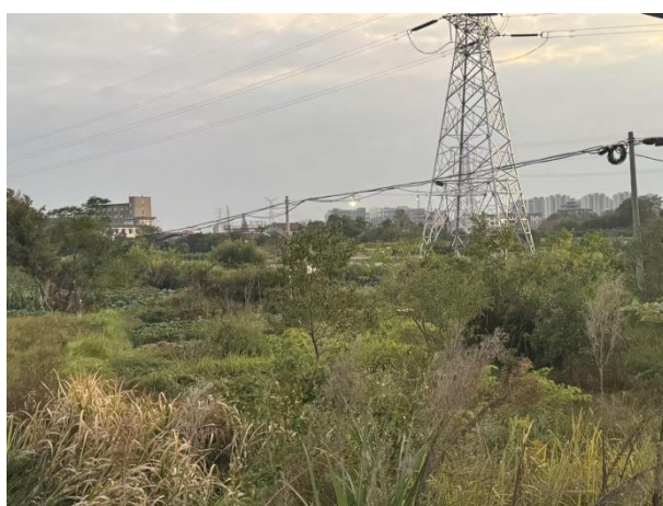
拆除塔基现状
